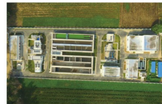
安徽亳州生活污水处理站项目
