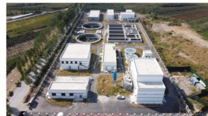
中建六局遵化古温泉旅游度假区污水和中水厂项目
