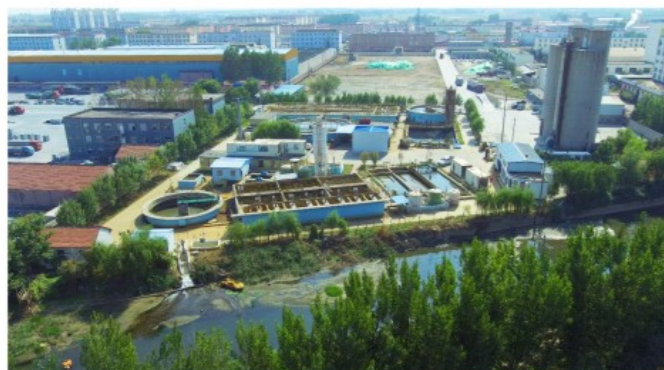
中建七局陕西铜川王家河工业园污水处理厂项目
